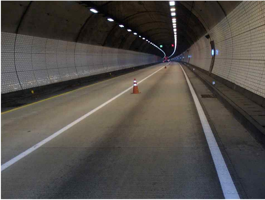
터널 내부 전경
