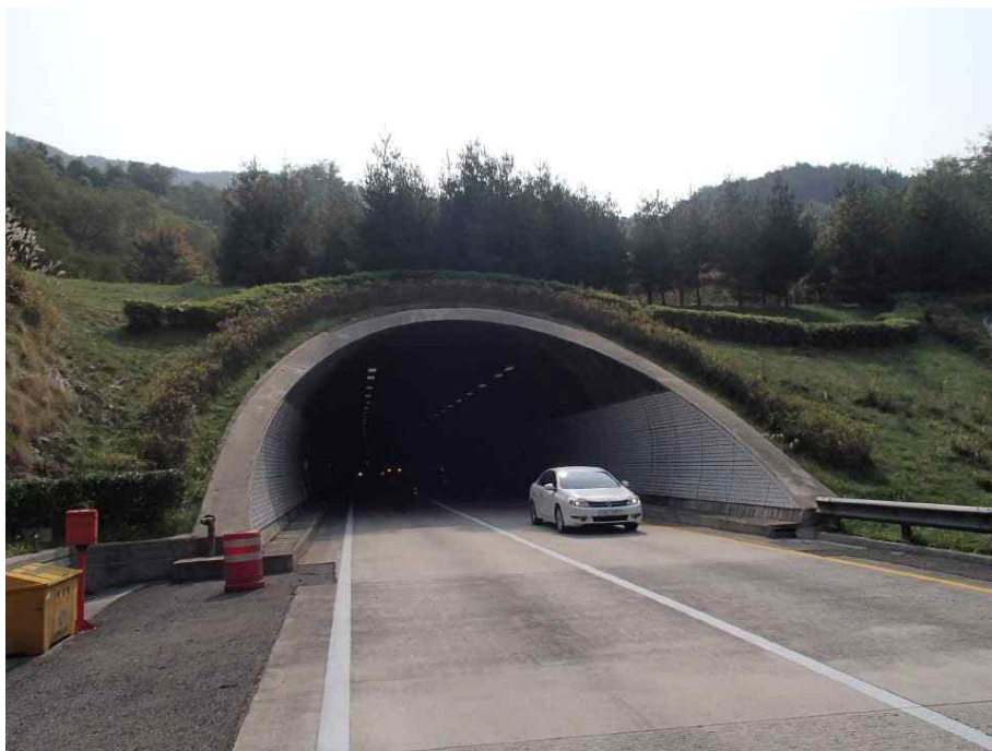
종점측 입구부 전경
