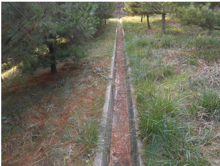
사면 배수로 전경
